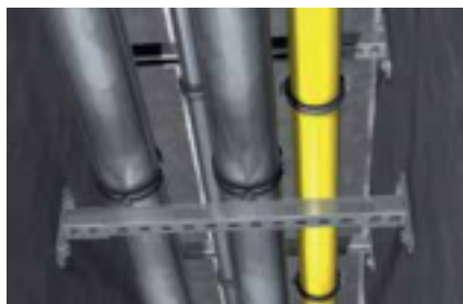
Csőszerelések menekülési útvonalaknál
