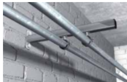
Csövek rögzítése konzolokhoz
