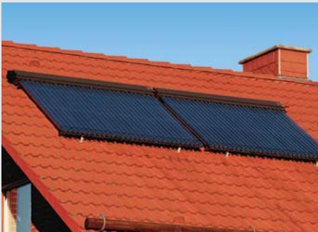
„Heatpipe“-elven működő vákuum- csöves rendszer
